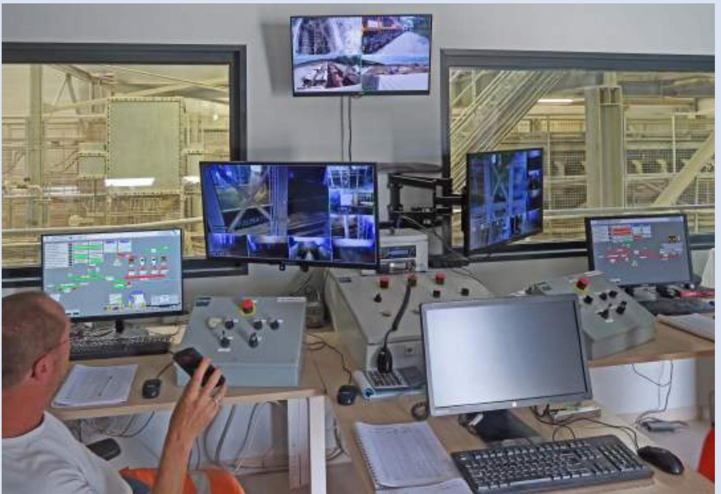
La salle de contrôle du nouveau terminal ferroviaire : à droite les consoles de contrôle et de commande du chargement des granulats, et à gauche celles du chargement de la castine. Des caméras permettent de suivre à distance l'ensemble des opérations sur le terminal. La conduite et la télécommande à distance des deux locomotives Vollert KR150 est réalisée à l'aide des deux pupitres SNEF disposés sur chacune des tables devant les opérateurs – photographie Patrick Etiévant -
